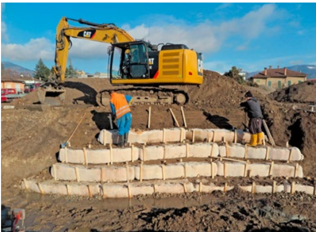
Einsatz von Holzwolle-Faschinen
