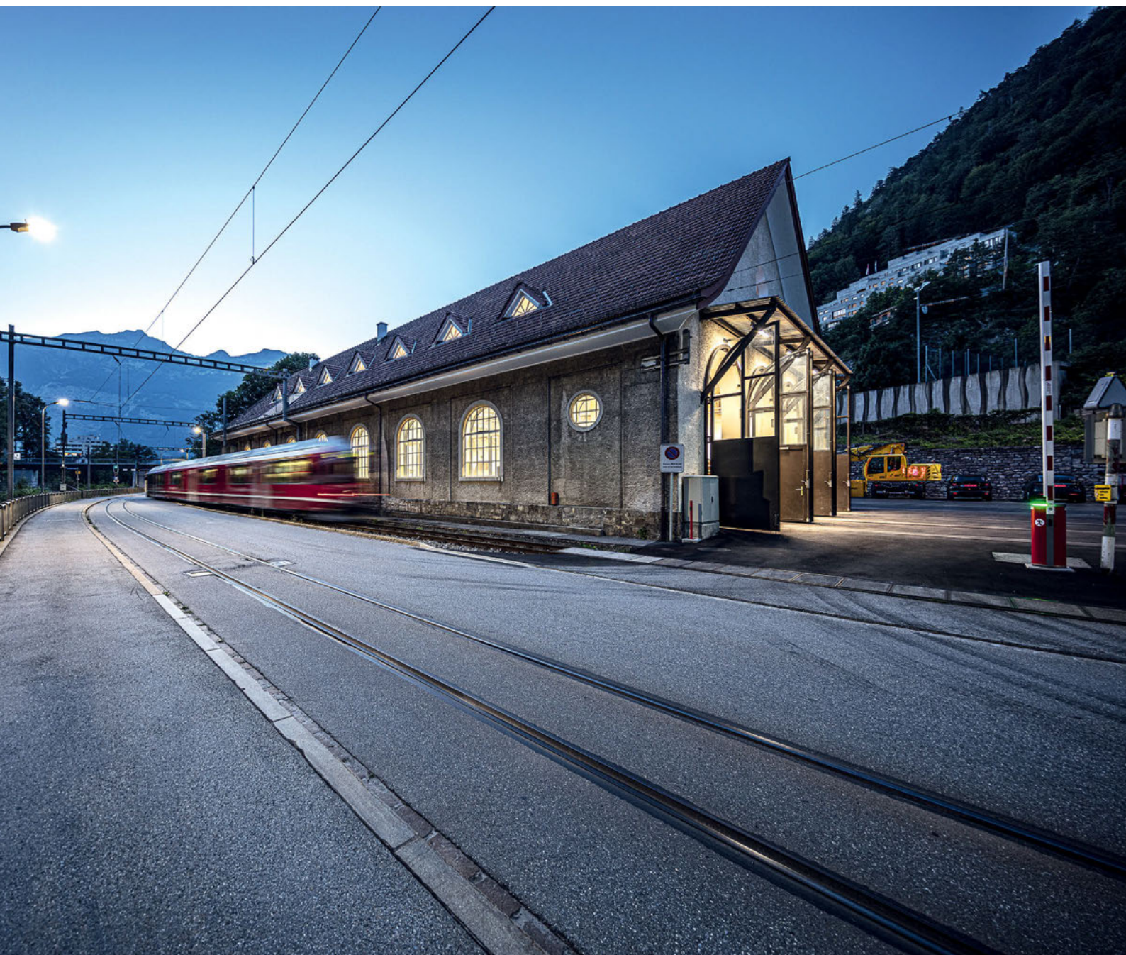
Depot Sand nach erfolgter Erneuerung
