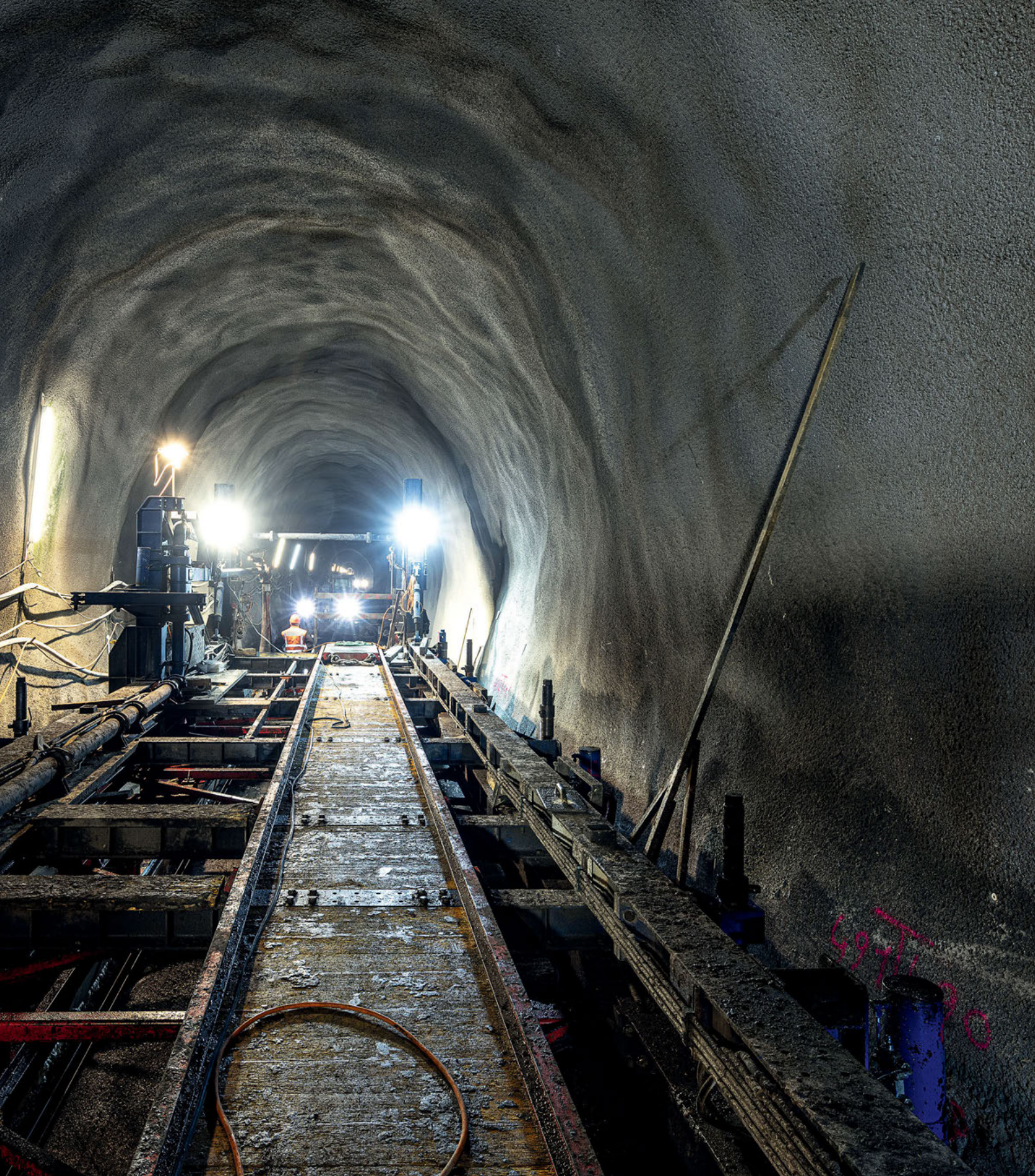
Innenausbau beim neuen Albulatunnel
